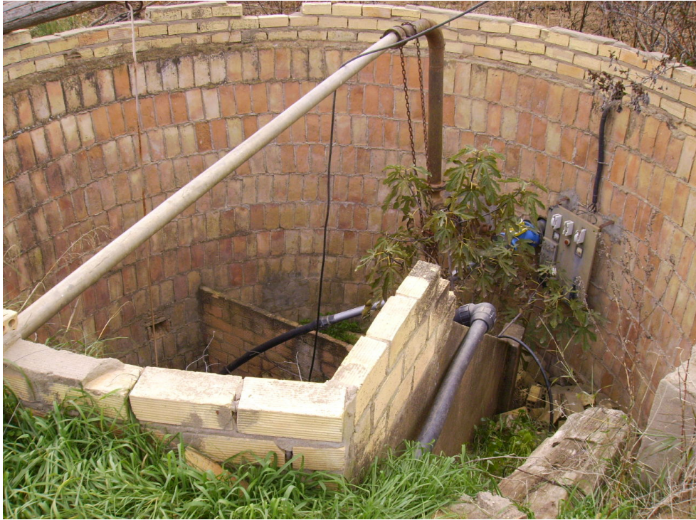
Pozo superficial próximo al sondeo Villanueva
